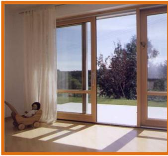
Sich im geöffneten Zustand überlappende Scheiben bilden physikalisch ein Vierfachglas, beim Einsatz von Dreifachisolierglas ein Sechsfachglas. Zwischen den Scheiben entsteht eine geschlossene Blase mit niedriger Luftströmung und die lokale Oberflächentemperatur von
